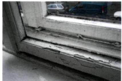
Auch dieses über Jahrzehnte vernachlässigte Kastendoppelfenster lässt sich auf moderne Standards aufrüsten.
