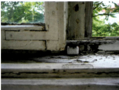
Stadt der Gründerzeithäuser: Bis 50 Jahre Auftragspotential bietet Berlin bei der Holzfenster-Sanierung.
