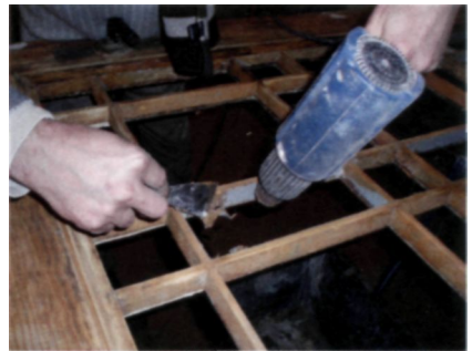
Vollständiges Abbrennen von brüchigen Beschichtungen
