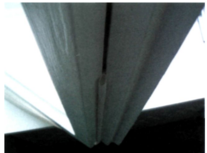
Schlauchdichtung in eingefräster Nut
