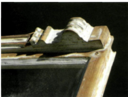
Erstaunlich: die hohe handwerkliche Qualität der alten Bauteile, die bei der Sanierung zum Vorschein kommt.
