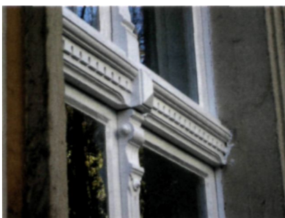
Es lohnt sich: Ob verrottet oder zugig, Dipl.-Ing. Martin Paal saniert alte Holzfenster nachhaltig und preiswert.
