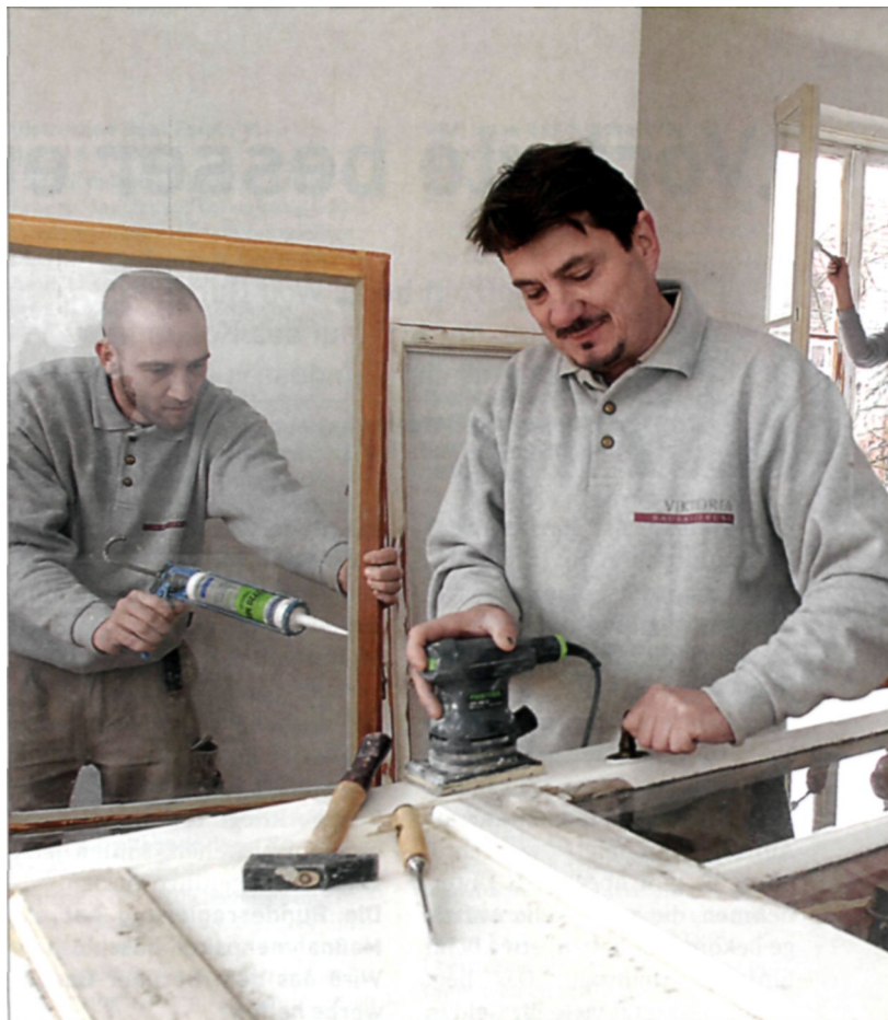
Fensterplatz: Zwei Mitarbeiter der Viktoria Bausanierung bei der Arbeit
