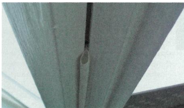
↑ Schlauchdichtung in eingefräster Nut
