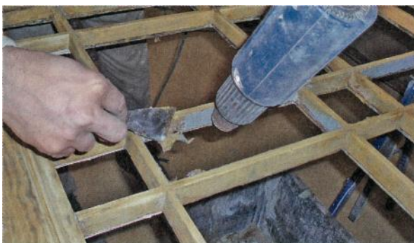
↑ Vollständiges Abbrennen von brüchigen Beschichtungen
