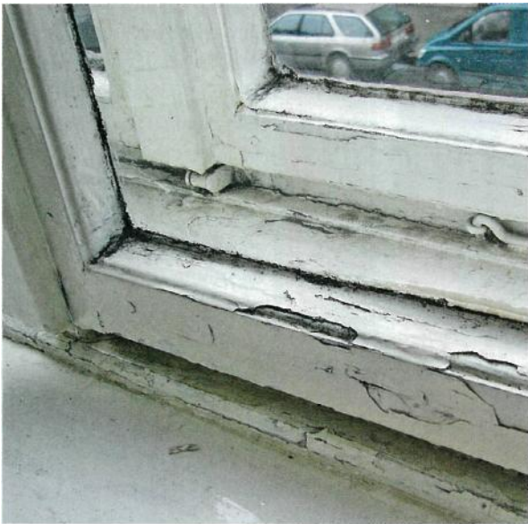
↑ Auch dieses über Jahrzehnte vernachlässigte Kastendoppelfenster lässt sich auf moderne Standards aufrüsten.
