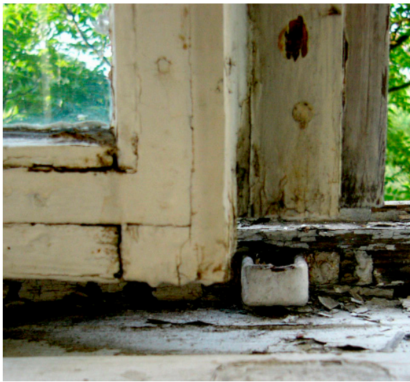
Es lohnt sich: ob verrottet oder zugig, Architekt Paal saniert alte Holzfenster nachhaltig und preiswert.
