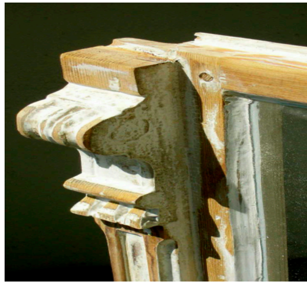
Erstaunlich: die hohe handwerkliche Qualität der alten Bauteile, die bei der Sanierung zum Vorschein kommt.
