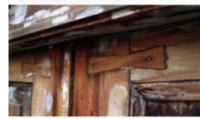
Foto 2: Dank eines sich nach zwei Seiten öffnenden Schwalbenschwanzes ist eine nachträgliche, zweidimensional kraftschlüssige Verbindung
