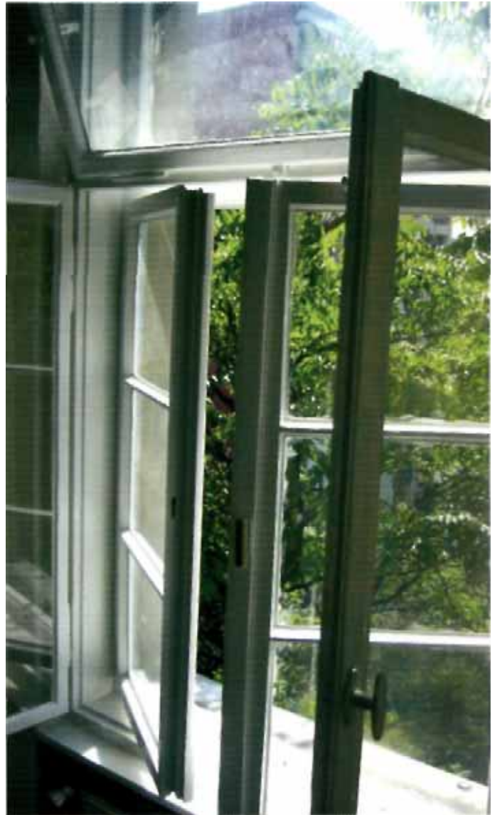
Doppelkassenfenster können durchaus erhalten und heutigen Standards angepasst werden.
